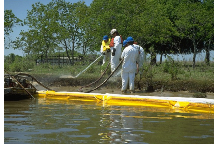
استعمال حاجز تطويق طاف ماص أثناء عمليات التنظيف بالضغط العالي (photos.orr.noaa.gov) المرجع
