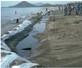
حفر خندق على طول الشاطئ لتجميع النفط المرجع (response.restoration.noaa.gov)
