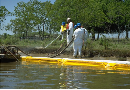
احتواء النفط المنفذ من التنظيف بالحواجز الطافية المراجع (photos.orr.noaa.gov)
